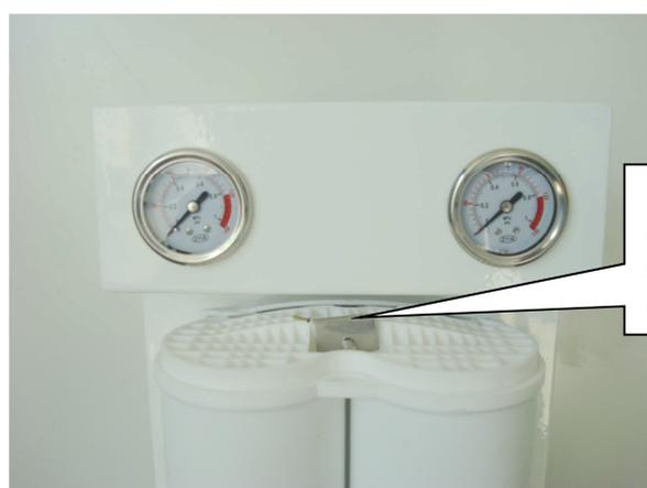
Insérez la clavette de verrouillage dans l'encoche de la broche.
